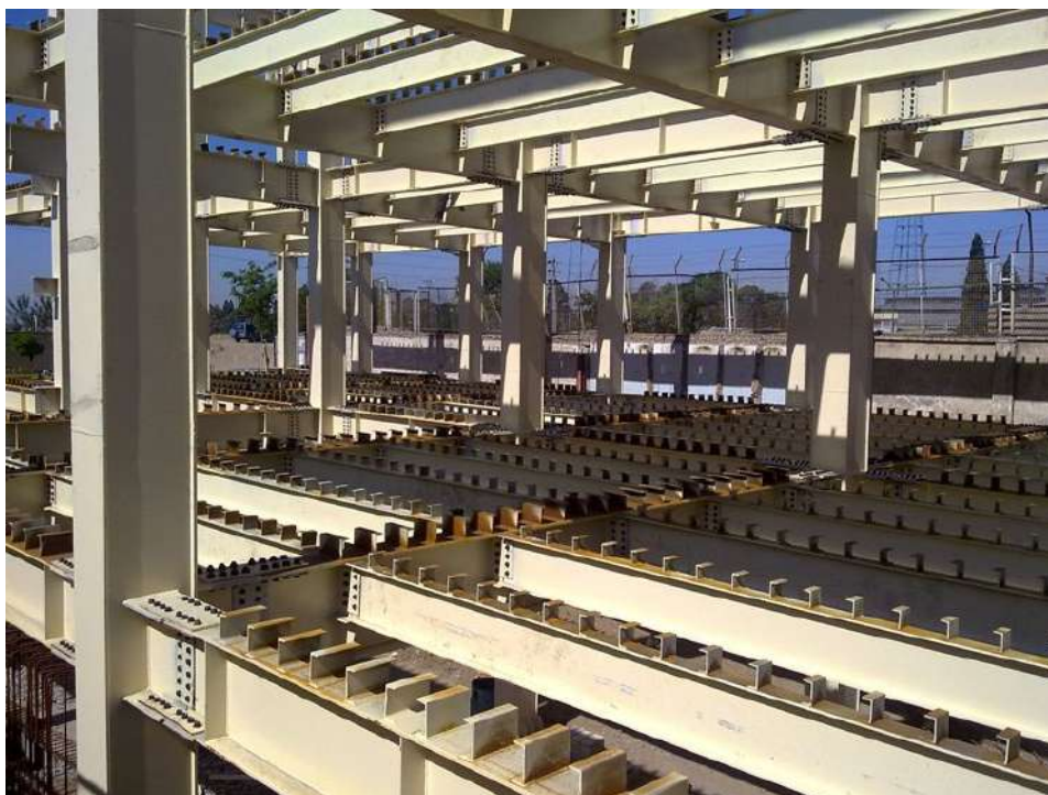
سازه ساختمان تحقیقات و توسعه (شرکت سایپا)
