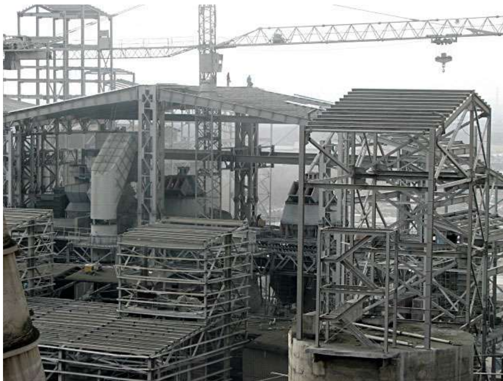
سازه ساختمان آسیاب سیمان (کارخانه سیمان آبیگ)
