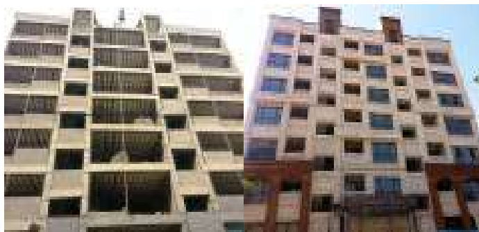
ساختمان مسکونی حسینی
