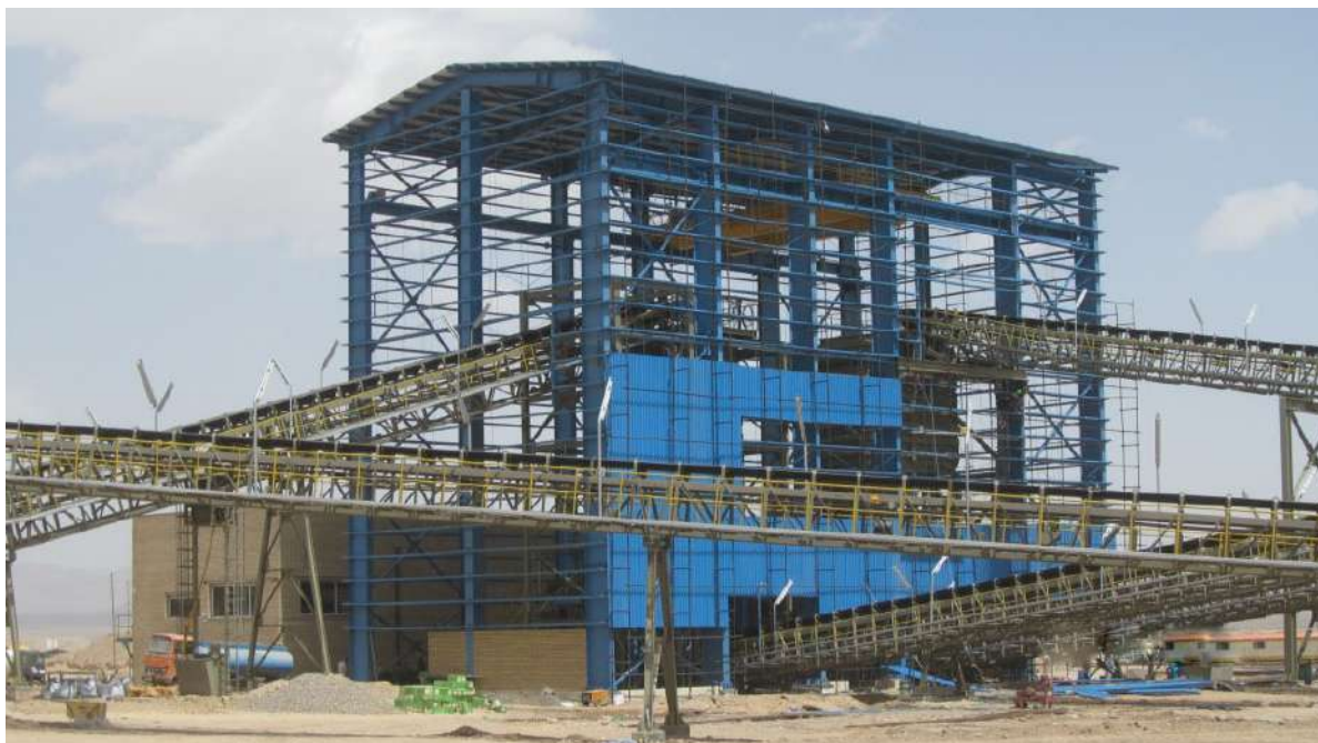
سنگ شکن ثانویه و کانوایرهای پلی کام (گل گهر سیرجان)
