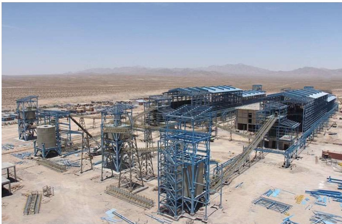
ساختمان‌های پروژه گلفا (گل گهر سیرجان)
