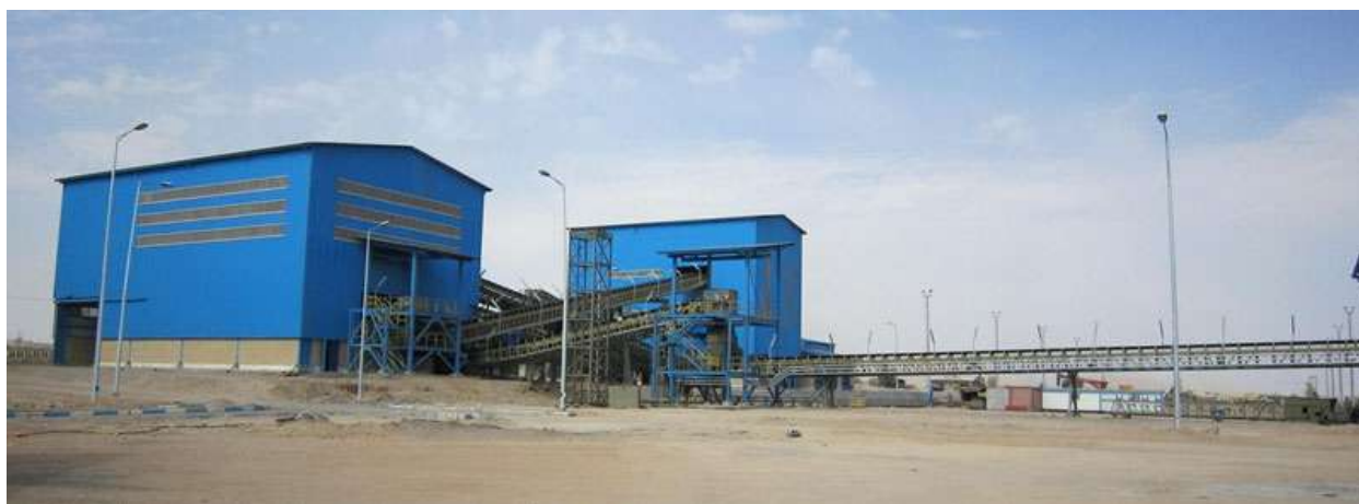
ساختمان های سرنده و سنگ شکن ثانویه و کانوایرهای رابط پروژه پلی کام (گل گهر سیرجان)
